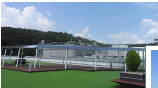
용인사업장 태양광 설치
